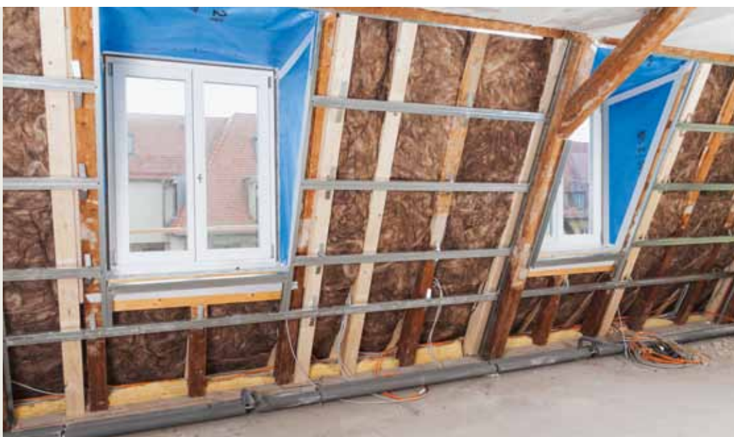
Innenansicht der Mansardflächen: Neben der Aufsparrendämmung sah das energetische Konzept eine Klemmfildämmung zwischen den Sparren vor.
