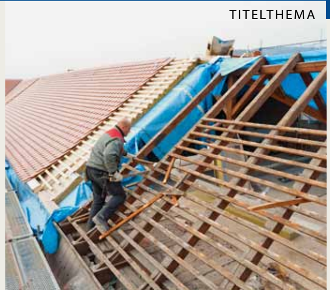
Der Abriss und die Neudeckung der Dachfläche erfolgen in Teilstücken.
